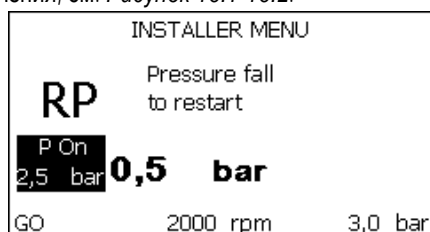
Рисунок 18.1: Настройка давления нового включения (1)
